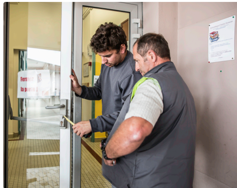
Les services techniques de la commune remettent la porte d'entrée en état
