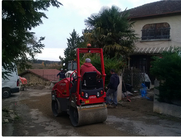
Un grand chantier pour une petite commune
