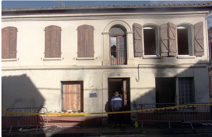
Incendie dans les locaux de France Terre d'Asile
