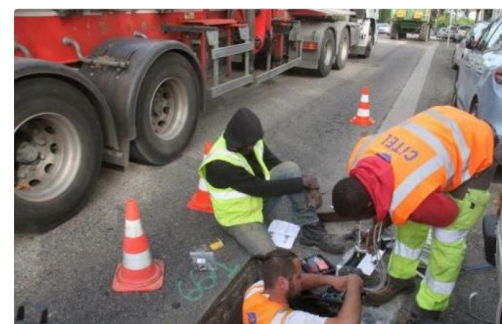
Pose du câblage. (Photo : Marc Le Saux).
