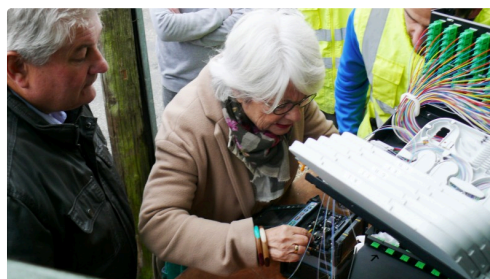
Sous l'œil de Bernard Gendre, Gisèle Biémouret s'initie au branchement de la fibre optique.
