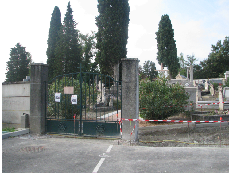
Les travaux au cimetière continuent
