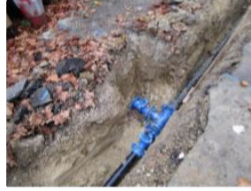
Modernisation du réseau d'eau potable
