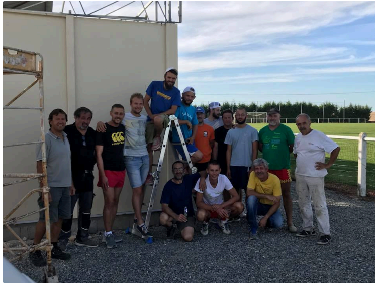
Des travaux au stade de Labarthète
