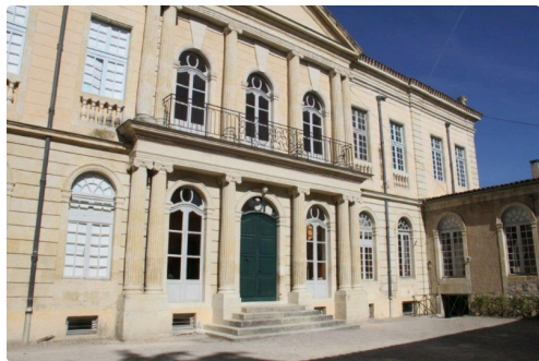
Façade Est de l'hôtel Polignac.
