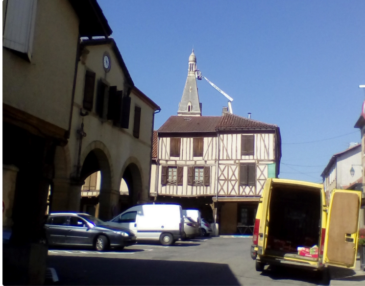
Un chantier vertigineux
