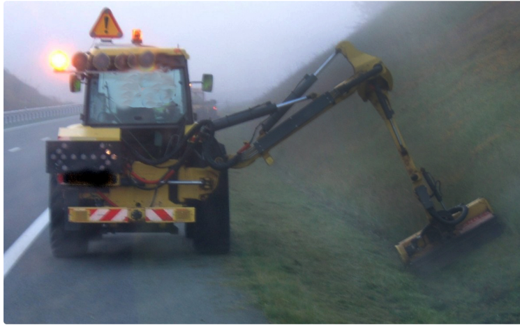
Accident de chantier routier
