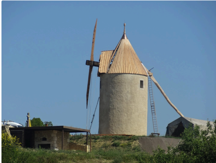
Le moulin à vent, sorti de ses ruines, bientôt opérationnel
