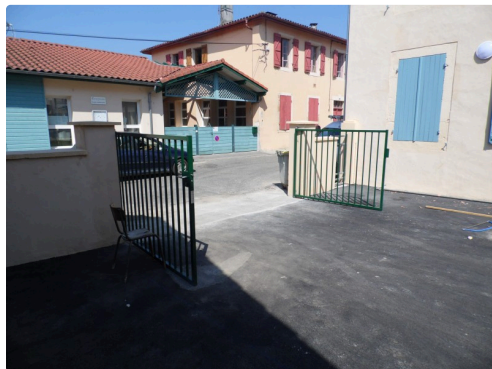
Portail d'entrée et portillon latéral en place
