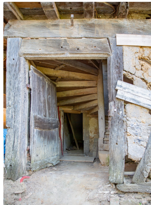
...avec la porte donnant sur l'escalier
