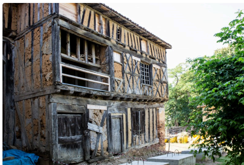
Façade arrière du Castet...
