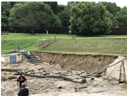
Après le passage de l'orage
