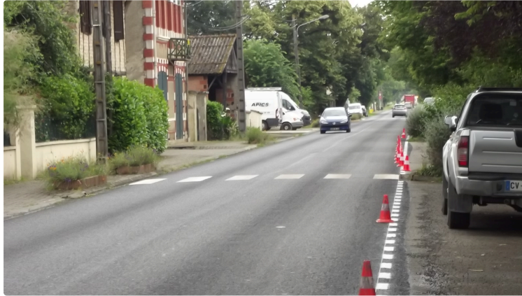
Rénovation de l'allée Bonnet
