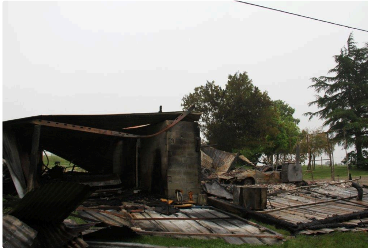
Incendie à la Pena de Condom
