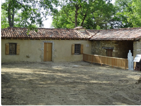
La bergerie restaurée
