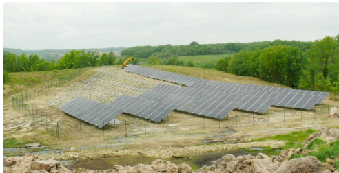
500 panneaux photovoltaïques sont posés sur les 832 prévus.
