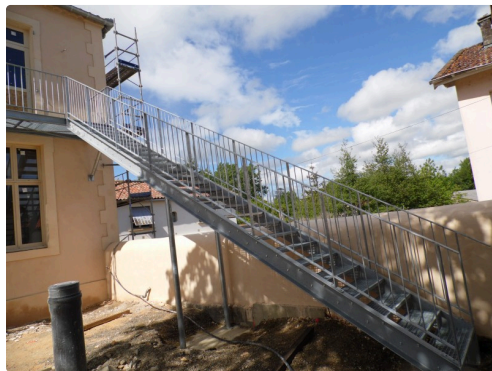
L'escalier de secours incendie est posé
