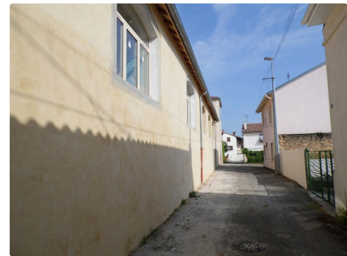
Les enduits terminés côté "Rue Basse"
