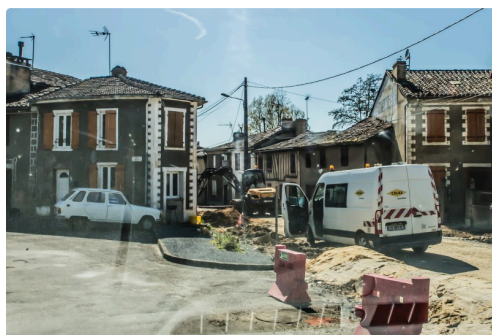
Les travaux en ville basse à Manciet
