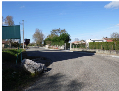
Une belle voirie pour le lotissement
