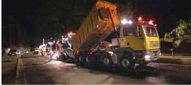
La DIRSO communique : Travaux de réfection de chaussée sur la RN 21
