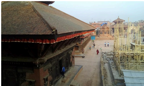
Baktapur, un site encore en reconstruction.
