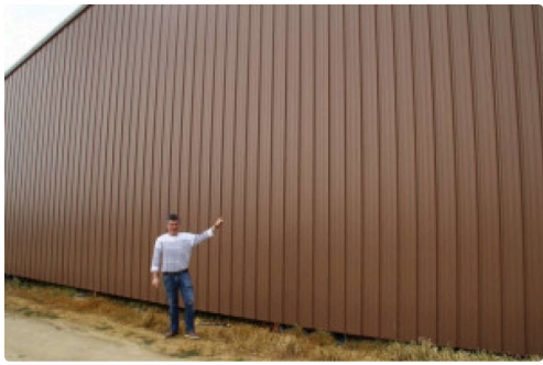
La grande surface métallique
