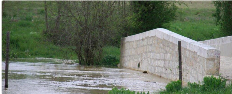
la rivière de l'Osse déborde au pont de Lartigue
