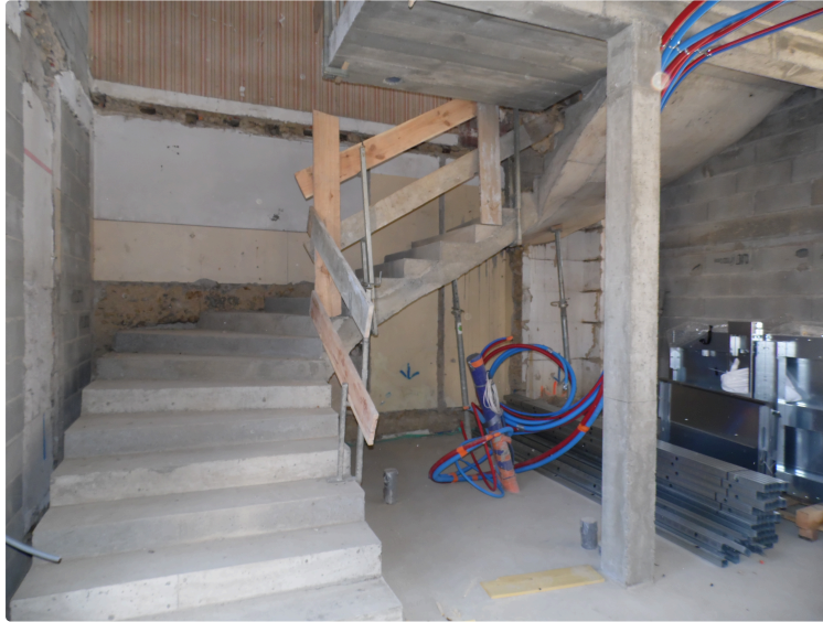
Rénovation complète de l'école Olléris
