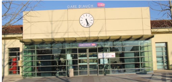
La ligne de train Auch-Toulouse ne doit pas fermer !
