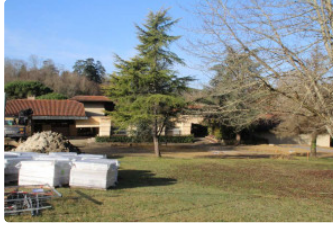
Le grand chantier a débuté
