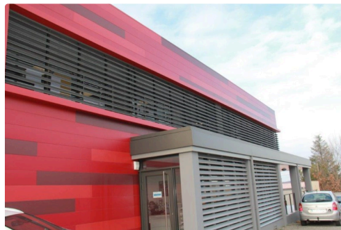
le hall et une partie des bureaux
