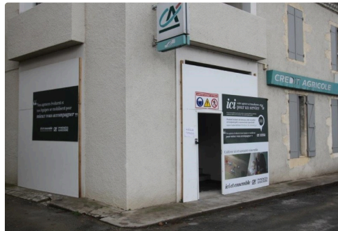
L'agence bancaire en travaux-Photos Marc Le Saux
