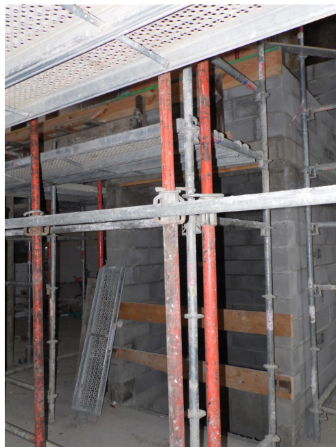
Bâtiment N° 1 la cage de l'ascenseur atteint le niveau de l'étage
