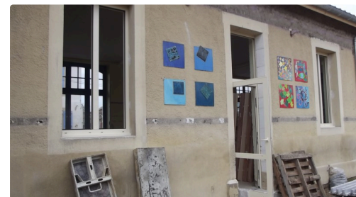
Les menuiseries posées coté cour du bâtiment N°2
