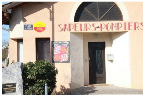
La caserne des Sapeurs-Pompiers
