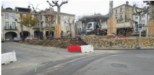
Travaux de démolition place du kiosque
