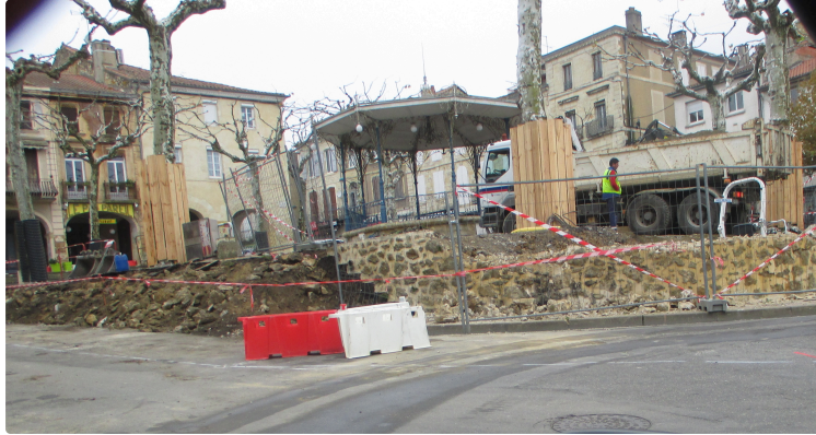
Travaux nouvelle place
