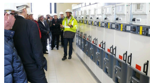
Les coulisses du transformateur.
