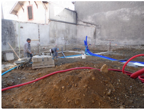
L'espace arrière du bâtiment N° 1 accueillera la chaufferie
