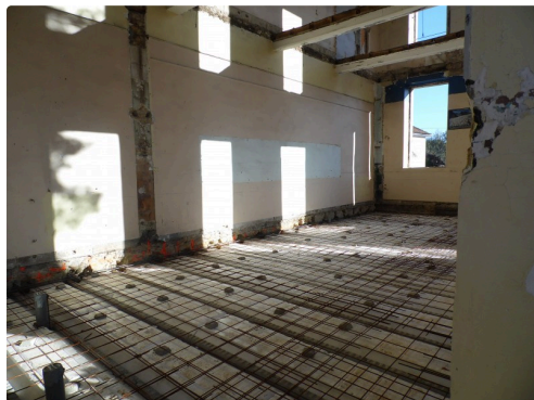
Le sol sur cave du rez de chaussée du bâtiment N° 1 coté rue basse
