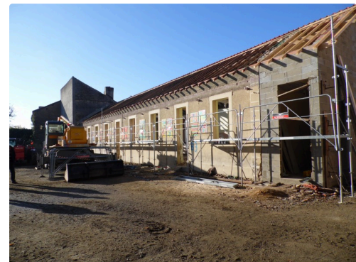
Le bâtiment N° 2 coté rue Sainte-Quitterie la toiture coté rue est faite
