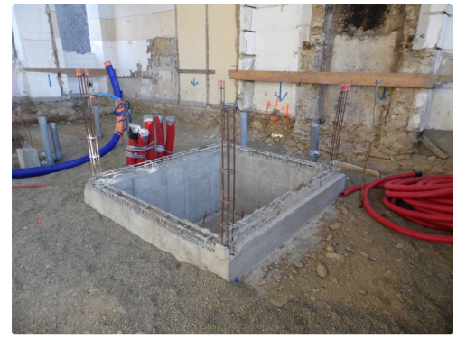
La fosse de l'ascenseur située dans le bâtiment N°1 coté rue Sainte Quitterie
