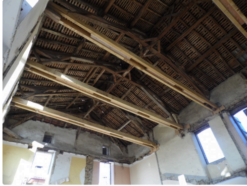
La charpente du bâtiment N°1 Photos Marcel Lavedan droits réservés
