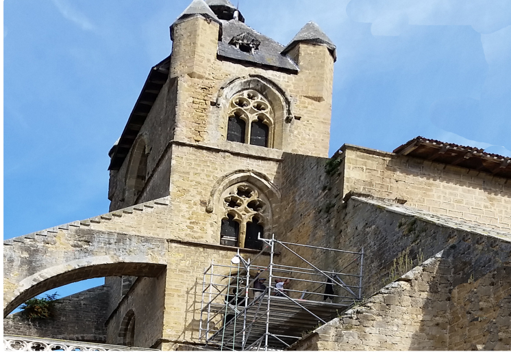
Eglise Sainte Marie, les travaux se poursuivent
