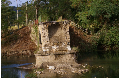
Dimanche matin ce qui reste à démolir pouvait encore se voir Photos Marcel Lavedan DR
