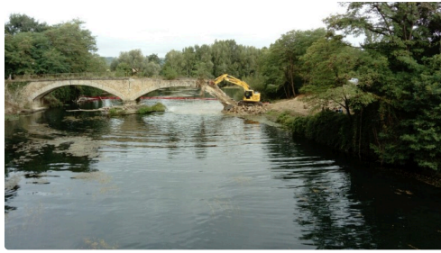
La pelle pousse l'arche en suspens
