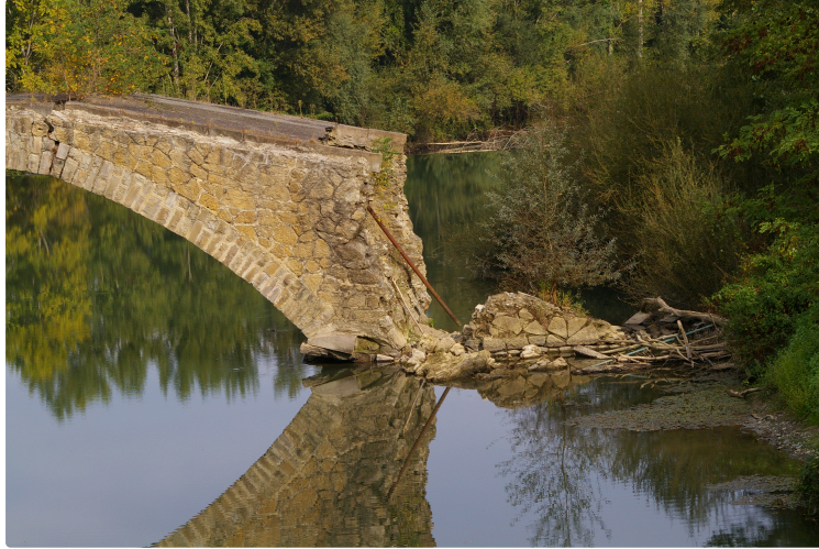
Déconstruction et aménagement des abords au pont de Hères
