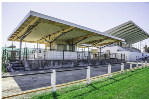
La buvette et tribune pour handicapés (des plaques de verre remplaceront la balustrade) ; état le 21 août
