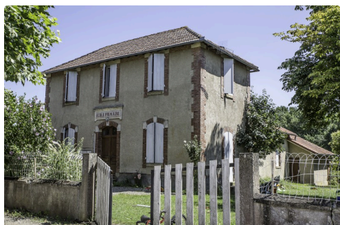
L'ancienne école convertie en logement social
