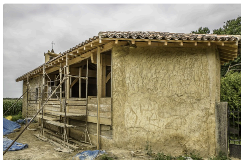
Le mur d'adobe en reconstruction, vu sous un autre angle
