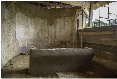
Le nouvel autel en adobe quasi terminé (il manque le plateau)
