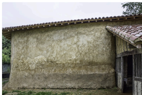
L'entrée se fait par l'annexe (côté opposé au mur en reconstruction)
