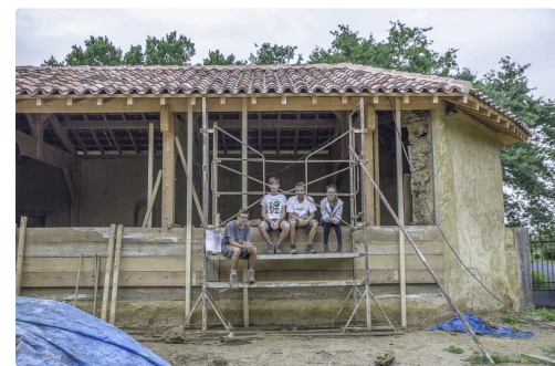
Gros plan sur la construction du mur de terre
