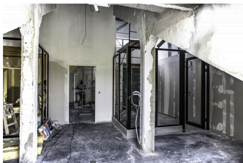
Entrée des vestiaires sous les tribunes (état le 27 juillet)
