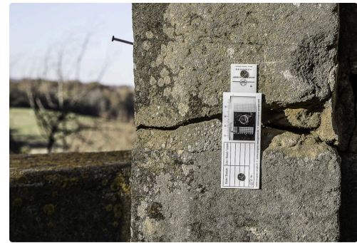
Il y avait ce témoin sur le portail avant les travaux
