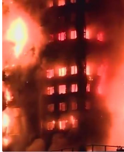
Une tour de 27 étages transformée en brasier à l'ouest de Londres.
