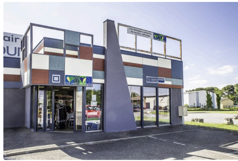
Façade de l'immeuble
