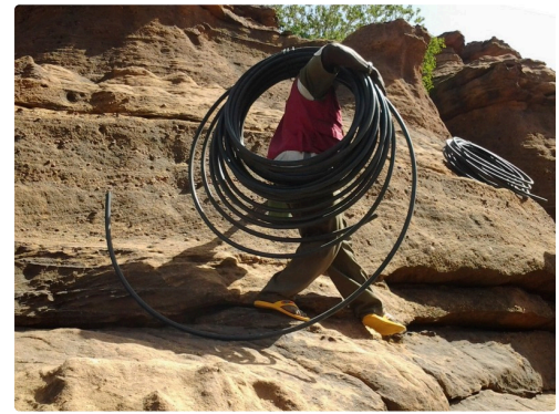
Pose de la conduite
