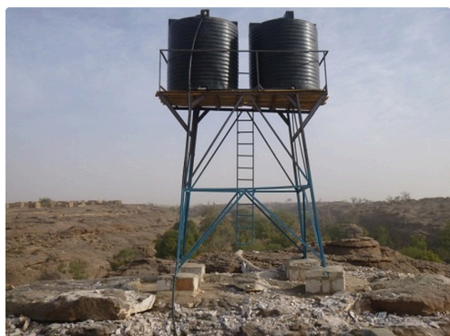
Mise en place d'une citerne
