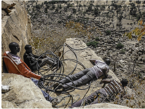
Pose de la conduite
