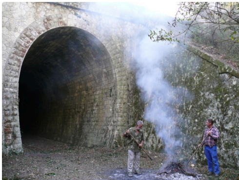
Tunnel de Castin.
