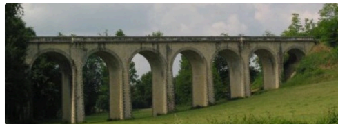
Viaduc de Castin.
