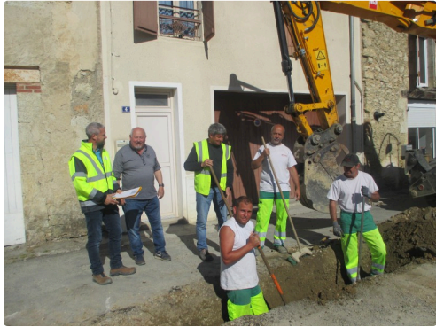
Travaux rue des Tisserands
