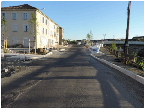
Rénovation du quartier Barlet et des voies de circulation
