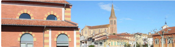
Samatan - Logements locatifs indignes occupés
