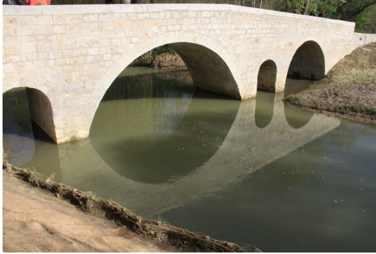
CONDOM Le pont Lartigue s'est refait une beauté
